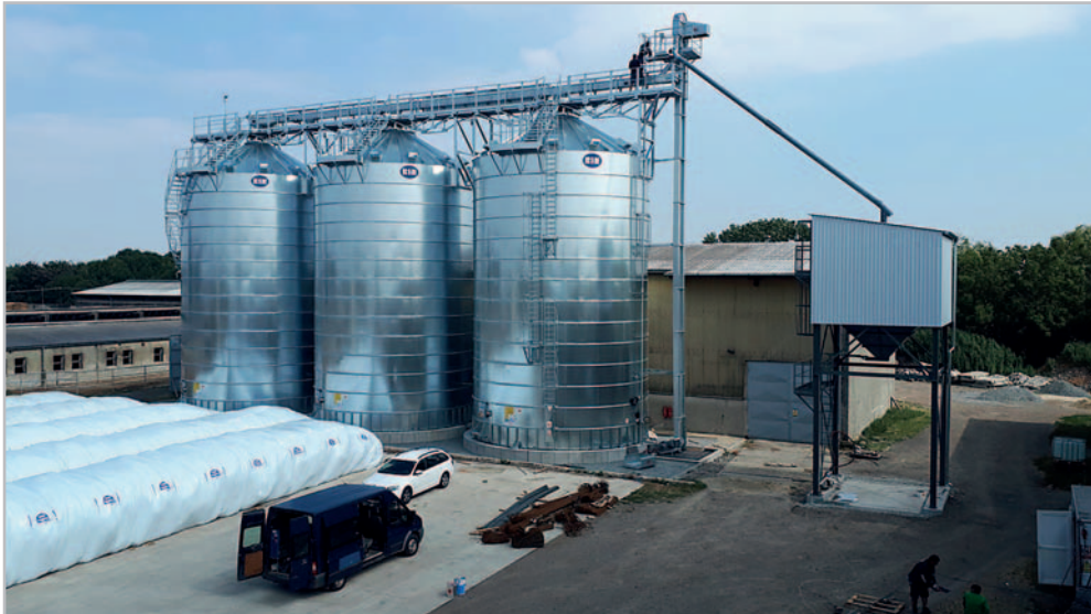
Polská pozinkovaná sila BIN rozšířila skladovací kapacitu v ZD Těšetice o 2415 m 3 Foto archiv firmy
