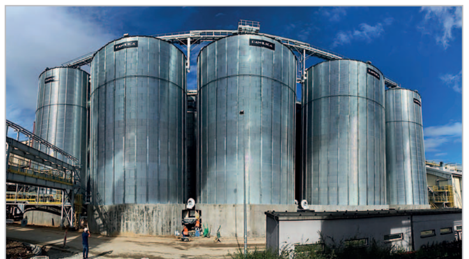
V polské společnosti BIOAGRA S. A., která je významným výrobcem bioetanolu, probíhá již čtvrtá stavební etapa. Firma PAWLICA s. r. o. zde dodala dvě sušárny BiTurbo MDB-XN 3/18 SB s enormním výkonem sušení 1000 t vlhké kukuřice denně a postavila sila se skladovací kapacitou přes 17 000 t Foto archiv firmy
