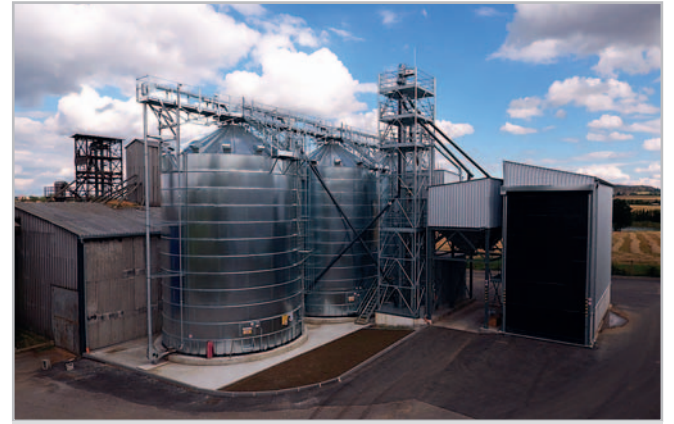
V ZD Křižanovsko byla v první etapě postavena nová posklizňová linka s kapacitou skladů 1626 tun, která je vybavena dopravníky SKANDIA o výkonu 60 t/h, příjmovou halou a čističkou obilí GEBR. RUBERG RVS 60 o výkonu 60 t/h Foto archiv firmy
