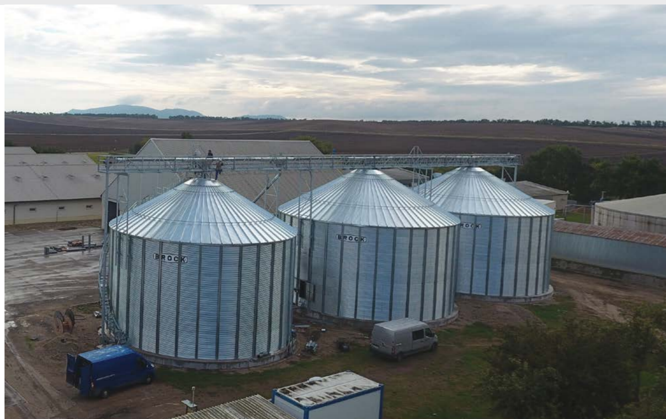
FIRSTFARMS GRANERO s.r.o., VLASATICE 3 x BROCK EVEREST 4 368 t, DOPRAVNÍKY SKANDIA INDUSTRY - I 100
