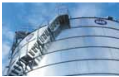
Schody Volitelné točité schodiště pro komfortní přístup ke kontrolním otvorům a lávkám. Opatřeno zábradlím a odpočinkovými podestami.
