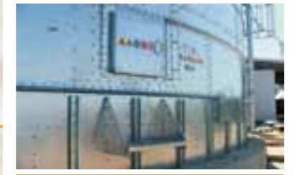
Inspekční otvory Společně s ostatními bezpečnostními prvky splňují nároky pro bezproblémový a bezpečný vstup do sila
