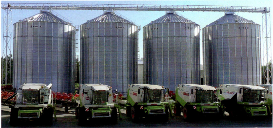
Skladovací sila s vloženou perforovanou podlahou pro aktivní větrání a s dopravním systémem „Grain Pump“ ZD Petřín a.s., Starý Petřín
